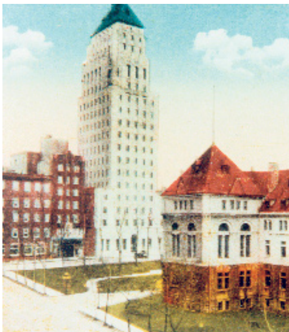
LE PREMIER GRATTE-CIEL DE QUÉBEC : LE BÂTIMENT PRICE EN VOIE D'ACHÈVEMENT, VERS 1930.
