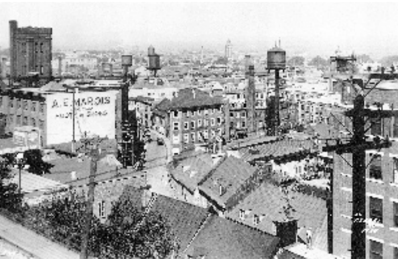
VUE DES USINES ET DES HABITATIONS OUVRIÈRES DU QUARTIER SAINT-ROCH, 1928. Archives de la Ville de Québec, Thaddée Lebel, négatif n° 17614.
